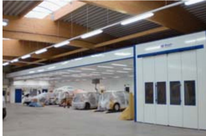
Die abgehängten Decken mit Beleuchtung und Belüftung sorgen für gute Arbeitsatmosphäre.
